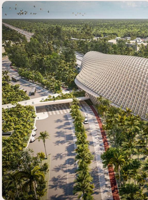
Estación del Tren Maya Tulum, que Conecta en 1,500 km con 5 Estados de la Península de Yucatán y con los aeropuertos de Cancun y Tulum.
